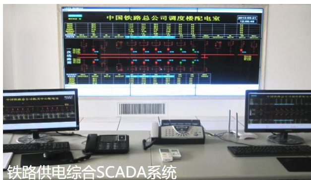
图61: 太格时代铁路供电综合 SCADA 系统
