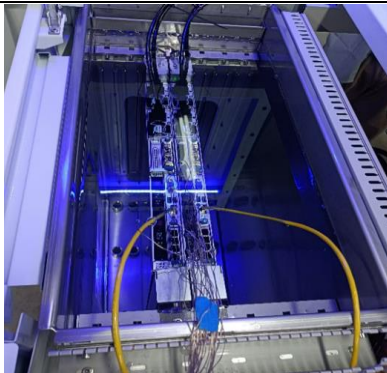
图3：G-Flow 浸没式液冷有效降低 TCO 和 PUE
