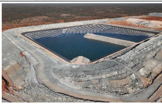
图34: 矿山配套的尾矿库
