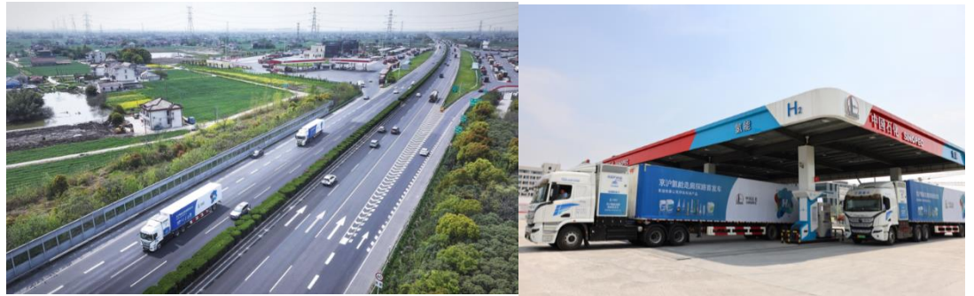
图表38：京沪氢能交通走廊，长距离跨省公路示范
