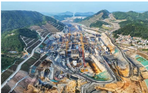
图5: 平陆运河马道枢纽建设现场
