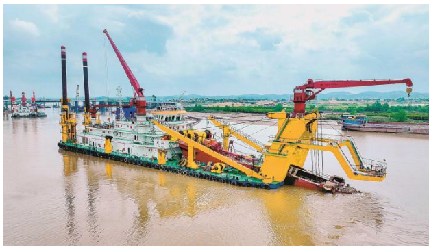
图6: 超大型自航绞吸船天鲸号参与平陆运河建设
